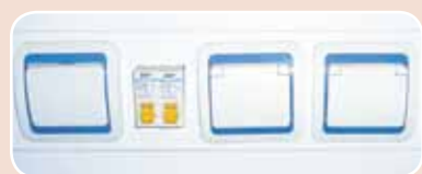
Электроблок вытяжного шкафа, состоящий из 2-х брызгозащитных розеток, 2-х автоматов защиты сети и выключателя светильника
